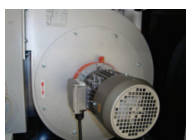
Moto -ventilateur / Fan and motor RSB 110-165
